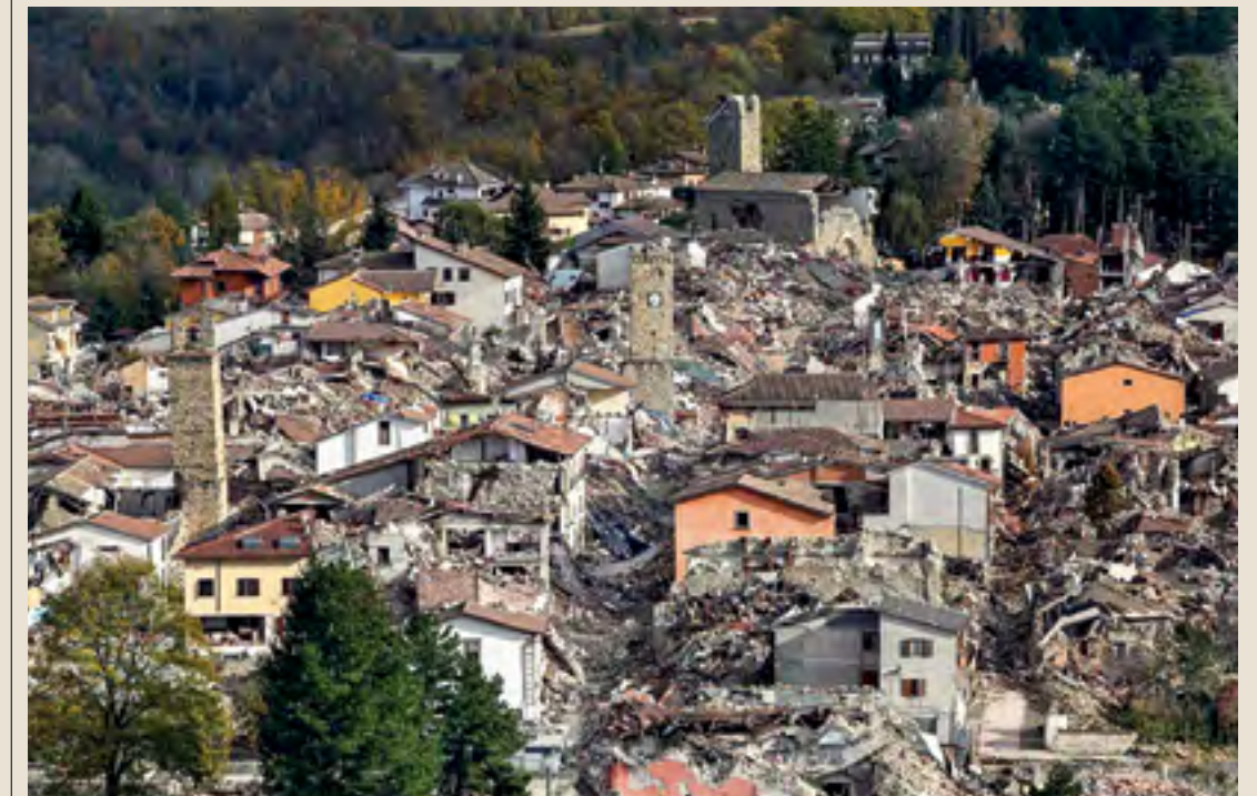
Terremoto 2016. Il centro storico di Amatrice.
