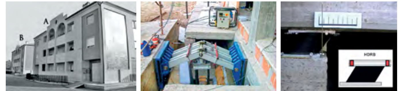
Figura 5. Edificio testato nel comune di Rapolla e particolare del sistema di isolamento alla base con HDRB.
